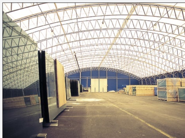
PMH Lagerhall har pelarfri golvyta och ljusgenomsläppligt tak.
